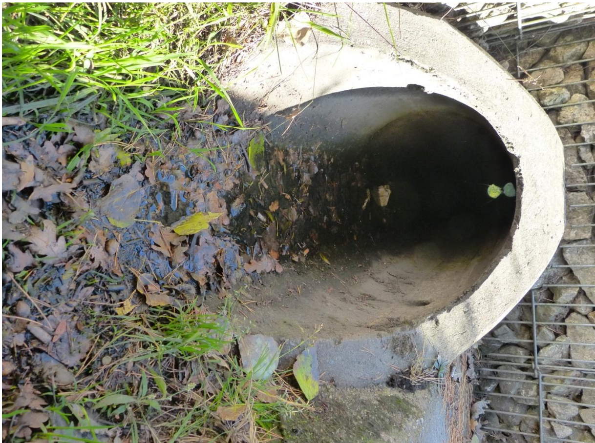
Grabensohle Grimbartgraben: ca 10 cm Schlamm an der Betonsohle
