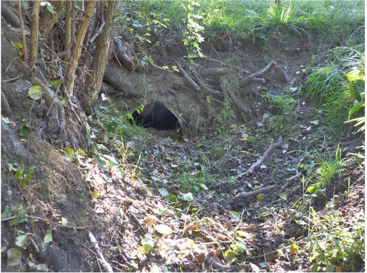
Blick von den anderen Seite in das Rohr unter dem Weg zum Nordfeld
