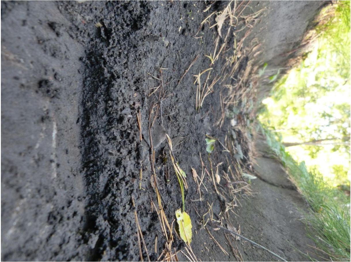
Grabensohle Grimbartgraben: ca 10 cm Schlamm an der Betonsohle
